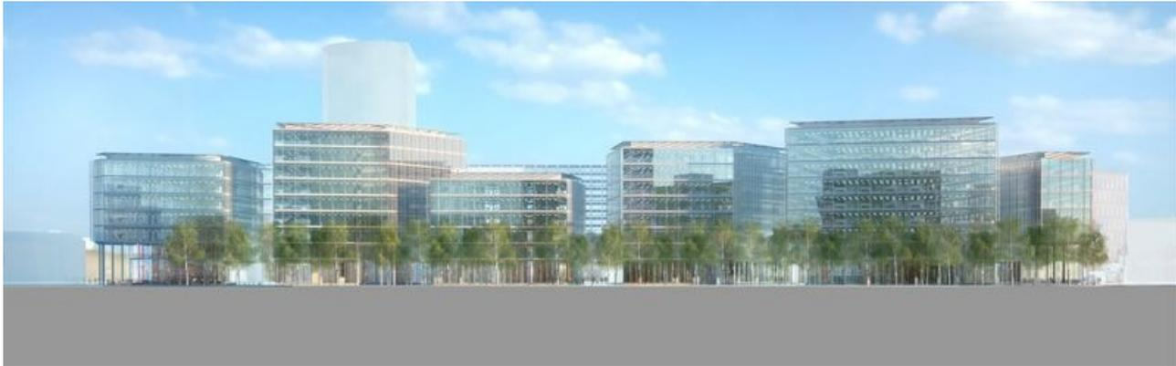
Das Ensemble mit einer Gesamtlänge von rund 200 Metern besteht aus sechs einzelnen Baukörpern, die über eine südseitig verlaufende sechsgeschossige Erschließungs-Magistrale und ein zusammenhängendes Untergeschoss verbunden sind. Die oberirdische Gesamtfläche von rund 31.000 Quadratmetern wird hauptsächlich als Headquarter eines Unternehmens genutzt werden. Daneben entstehen ausgewählte Gastronomie- und Einzelhandelsbereiche sowie eine Tiefgarage mit 780 Stellplätzen.
